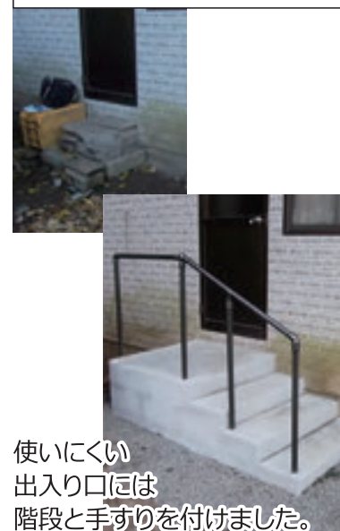
例2：手すりの取り付け
