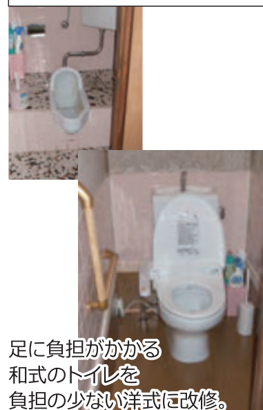
例1：トイレの改修工事
