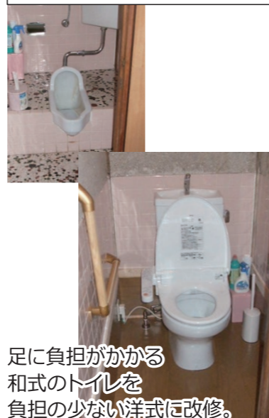
例1：トイレの改修工事
