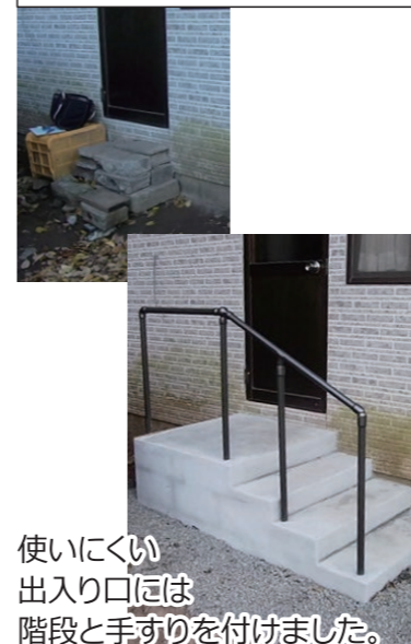
例2：手すりの取り付け
